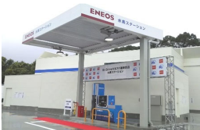
八幡東田水素ステーション (北九州市八幡東区東田)
