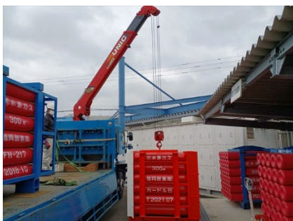
[ 水素カードル搬入 ]
